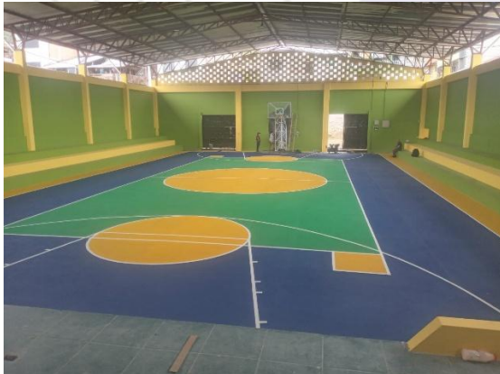
MANTENIMIENTO Y ADECUACION DEL COLISEO DE LA CABECERA PARROQUIAL DE INDANZA
