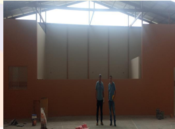
MANTENIMIENTO Y ADECUACIÓN DEL ESCENARIO DE LA COMUNIDAD PLAN DE MILAGRO DE LA PARROQUIA INDANZA
